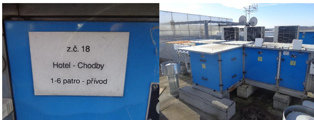
Foto 1 - Současný stav jednotka č. 18
