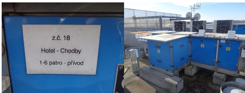
Foto 1 - Současný stav jednotka č. 18
