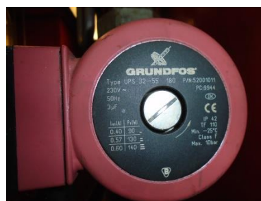
Obrázek 10 – Oběhové čerpadlo ohřívače
