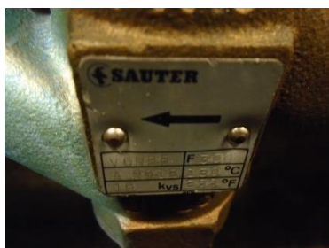
Obrázek 9 – Směšovací ventil ohřívače
