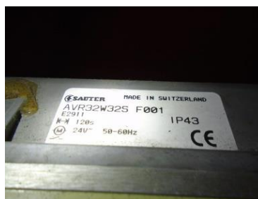
Obrázek 14 – Pohon ventilu chladiče
