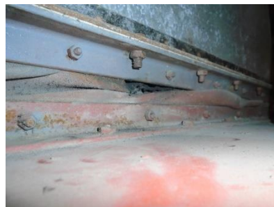
Obrázek 25 – Netěsnosti odvodní manžety
