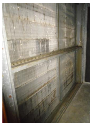
Obrázek 8 – Pohled na lamely ohřívače
