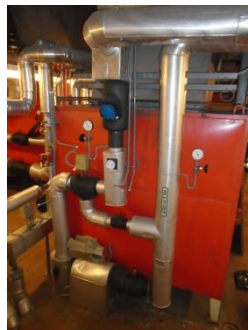
Obrázek 12 – Směšovací uzel chladiče
