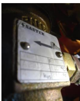
Obrázek 18 – Směšovací ventil dohříváče
