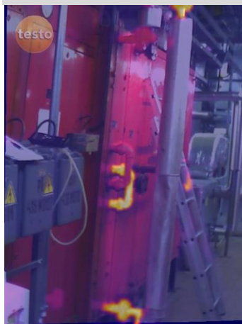
Obrázek 15 – Teplotní spád při měření výkon ohříváče
