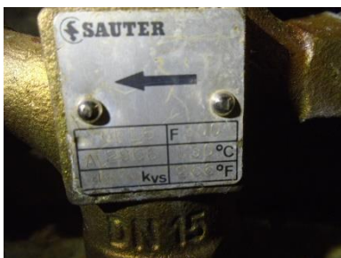
Obrázek 7 – Směšovací ventil ohřivače
