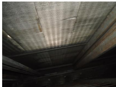
Obrázek 6 – Pohled na lamely ohřivače
