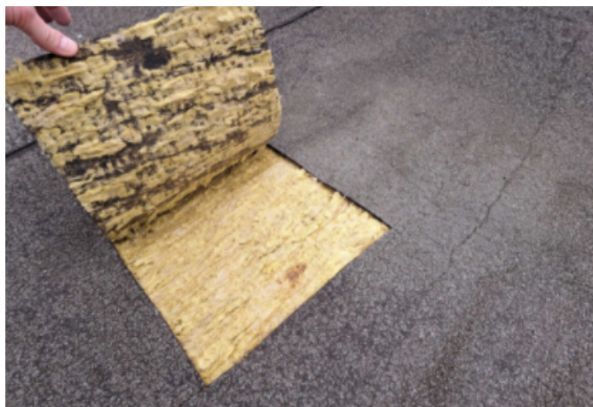
Foto /55/ Pohled na tepelnou izolaci v sondě
