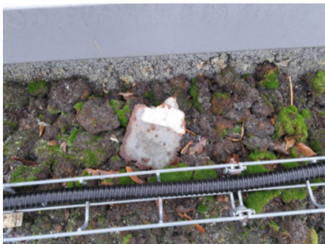
Foto /10/ Usazování mečů v okolí okrajů střechy
