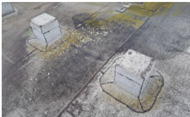
Foto /40/ Pohled na prostupující podkladní konstrukce pod technologické vybavení objektu
