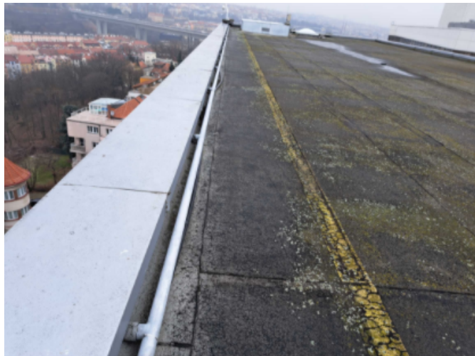
Foto /52/ Záchytné zařízení pro umývače oken
