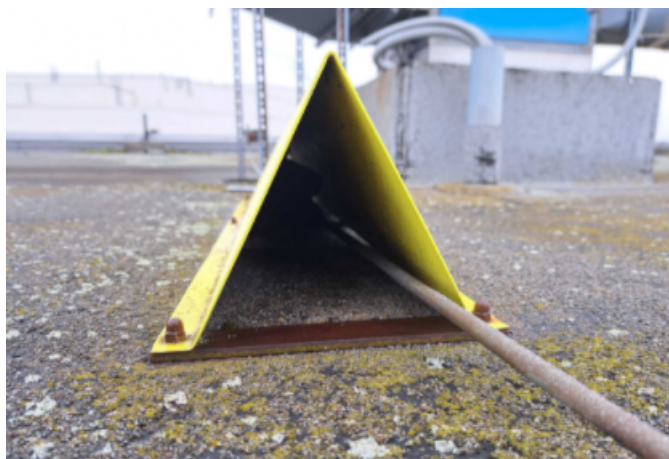
Foto /47/ Ochranné profily nad homosvodem
