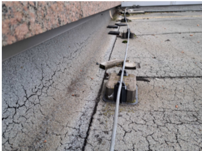
Foto /51/ Pohled na uložení hromosvodné soustavy v ploše
