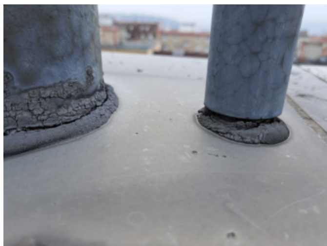
Foto /24/ Prostup konstrukce zábradlí skrz atiku
