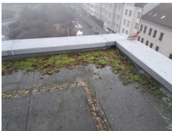
Foto /15/ Roh oplechování atiky
