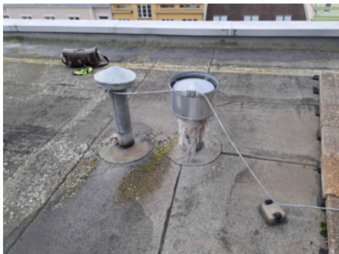
Foto /49/ Uchycení hromosvodu ke komínovým hlavicím
