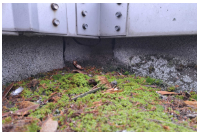
Foto /12/ Usazování mečů v okolí okrajů střechy
