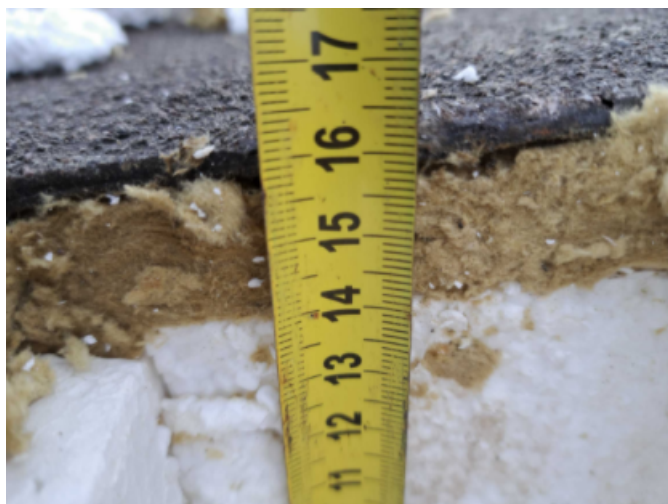
Foto /58/ Nejmenší tloušťka střešního souvrství
