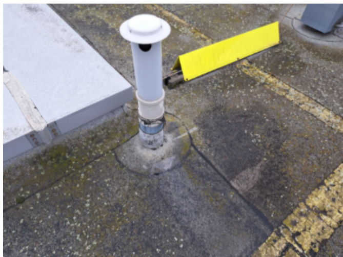
Foto /45/ Ochranné profily nad homosvodem
