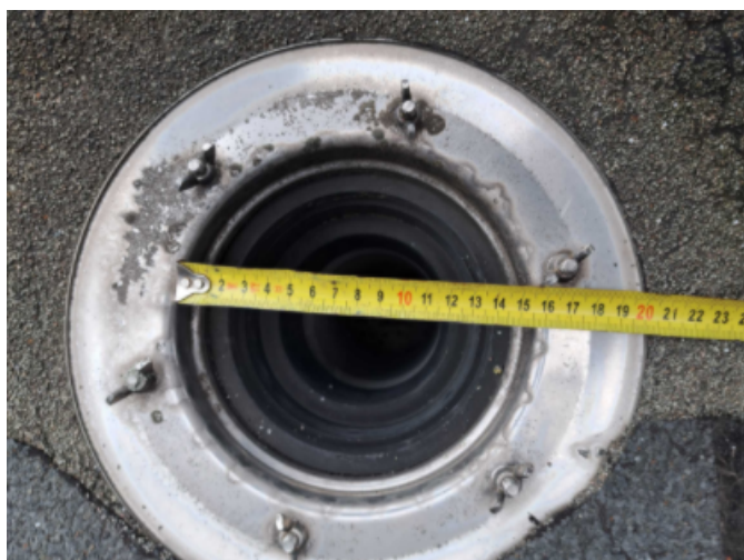
Foto /13/ Střešní vtok o vnějším průměru 150 mm a vnitřním 100 mm
