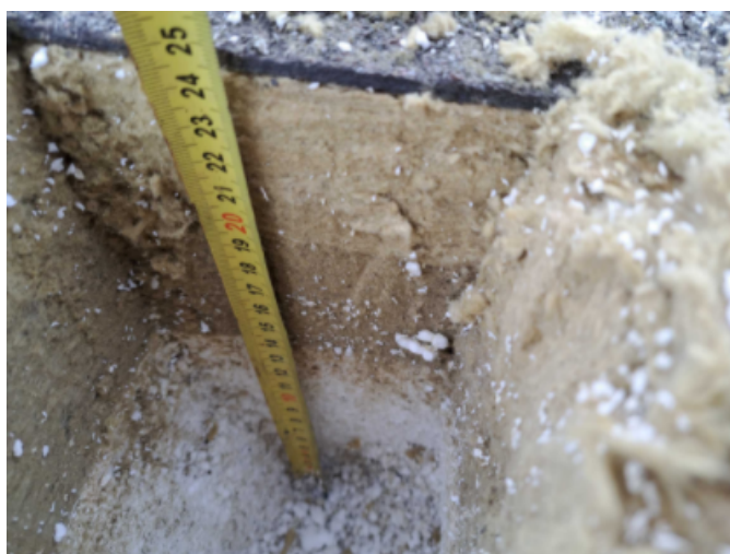
Foto /59/ Největší tloušťka střešního souvrství
