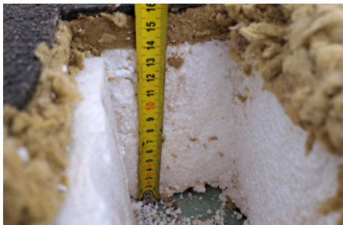
Foto /62/ Celková návaznost vrstev v střešním plášti v sondě S4
