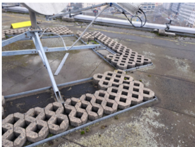
Foto /32/ Satelit na střeše zatížen betonovými zatravňovacími tvarovkami, položeno na asfaltových přířezech
