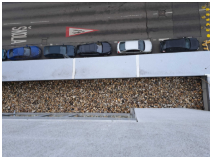
Foto /66/ Pohled na střešní rovinu z 5.NP
