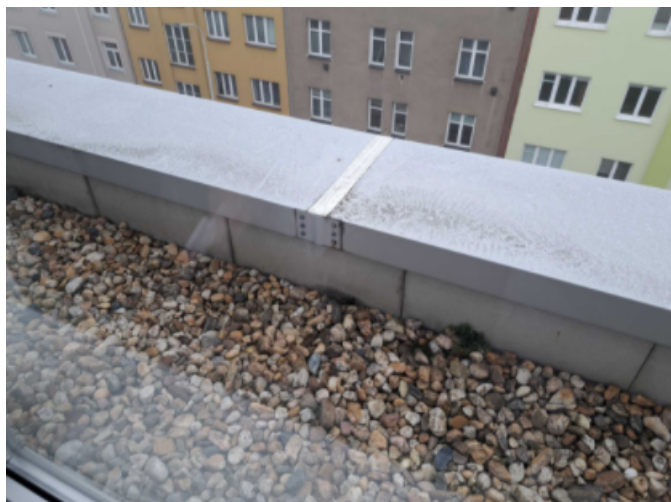
Foto /64/ Pohled na střešní rovinu z interiéru pokoje ve 4.NP
