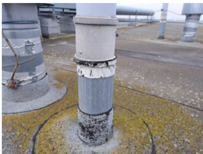
Foto /30/ Navazování různých materiálů pro komínek odvětrání, nesprávné přechody materiálů
