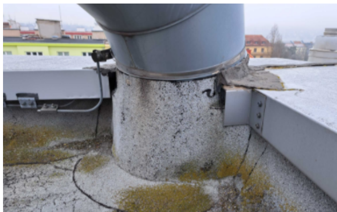
Foto /33/ Prostup konstrukce skrz střechu a oplechování atiky
