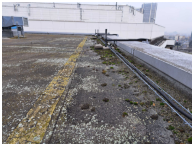
Foto /9/ Usazování mečů v okolí okrajů střechy
