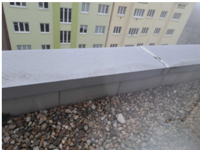
Foto /65/ Pohled na střešní rovinu z interiéru pokoje ve 4.NP
