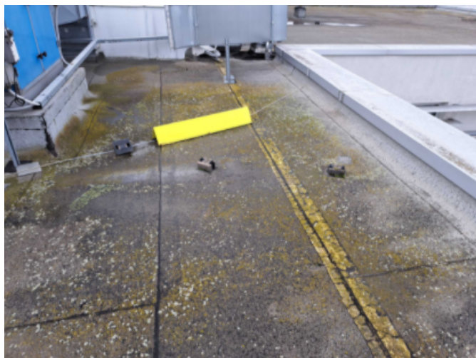
Foto /46/ Ochranné profily nad homosvodem
