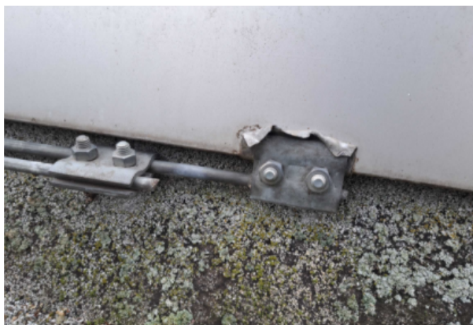
Foto /48/ Uchycení hromosvodu na oplechování atiky
