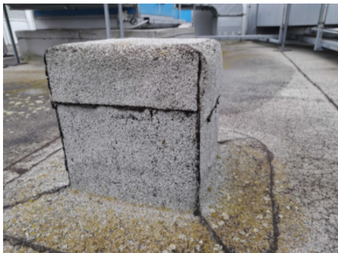
Foto /41/ Pohled na prostupující podkladní konstrukce pod technologické vybavení objektu
