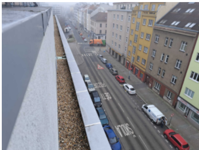
Foto /67/ Pohled na střešní rovinu z 5.NP
