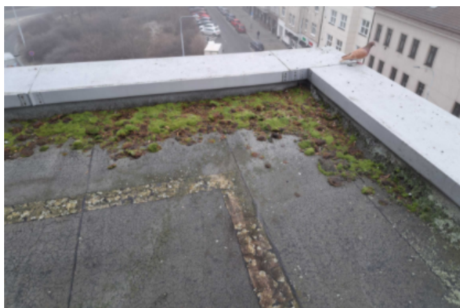
Foto /11/ Usazování mečů v okolí okrajů střechy
