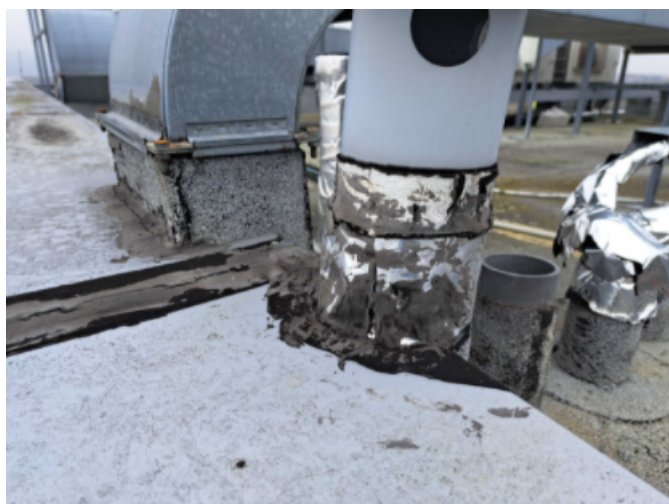
Foto /31/ Prvek prostupující jak střešní konstrukcí, tak oplechováním atiky
