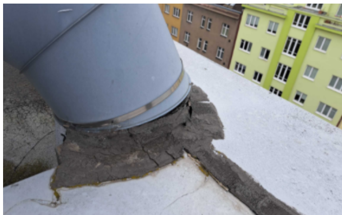
Foto /34/ Prostup konstrukce skrz střechu a oplechování atiky
